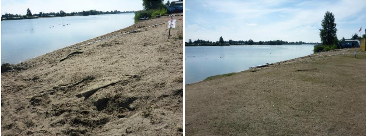
Sandstrand mit Abbruchkanten und freigetretetem Vlies – Liegewiese und Umfeldzone
