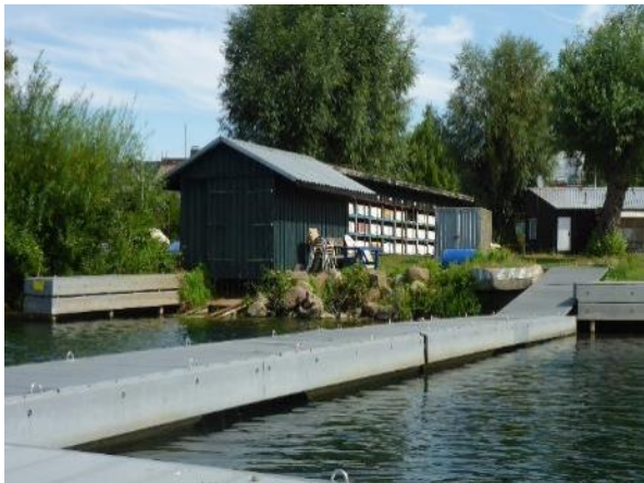
Segelclubgelände mit Alu-Stegen, Slipanlagen und Uferbefestigung aus großen Steinen
