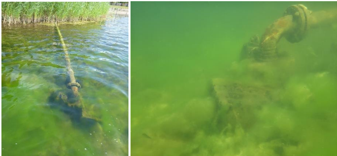
Metallleitung unbekannter Funktion (Einleitung?) im See (bei Flurstück 2360)
