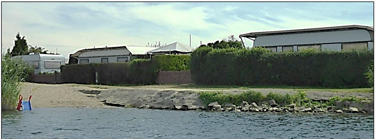
Abbildung 103: Beispiele für Uferverbau aus Holz, Stein und Teer in Abschnitt 8.
