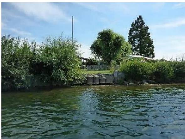
„Improvisierter“ Uferverbau aus Betonelementen, Steinschutt und Steinplatten
