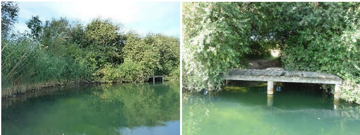
Defekter Angelsteg am nord-westlichen Ufer, umgeben von dichter Ufervegetation
