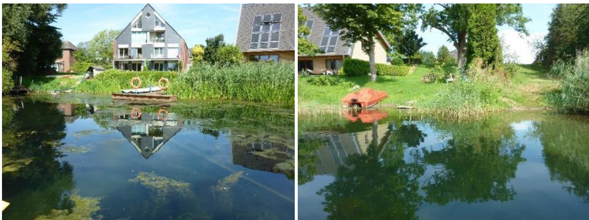
Bauten an den Ufern: Pumphauschen, Steege
