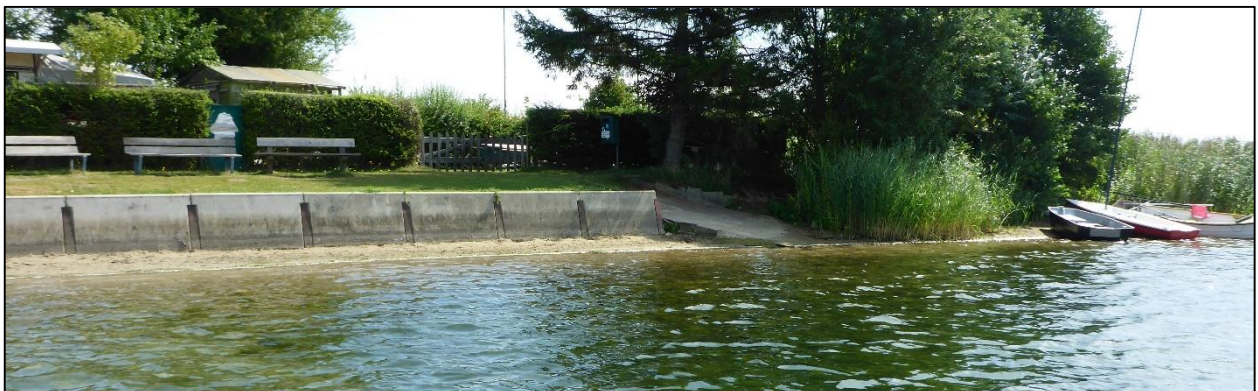
Abbildung 106: Beispiel Uferverbau in Abschnitt 10.
