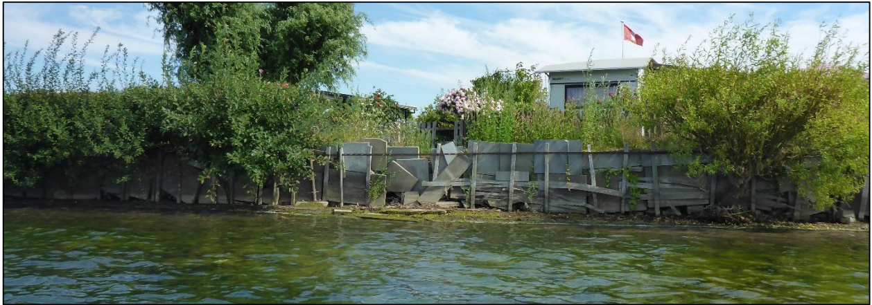
Abbildung 104: Beispiel Uferverbau in Abschnitt 8.
