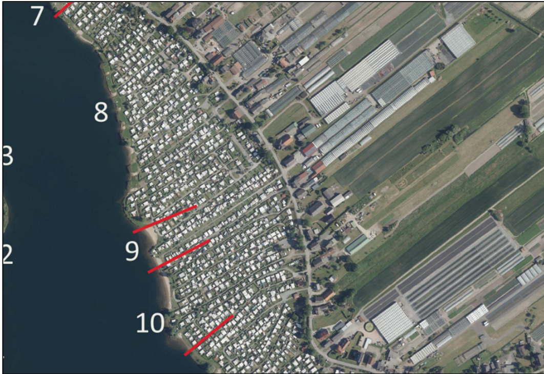
Abbildung 102: Uferabschnitte (8, 9, 10) mit stark bis vollständig veränderten Uferstrukturen.
