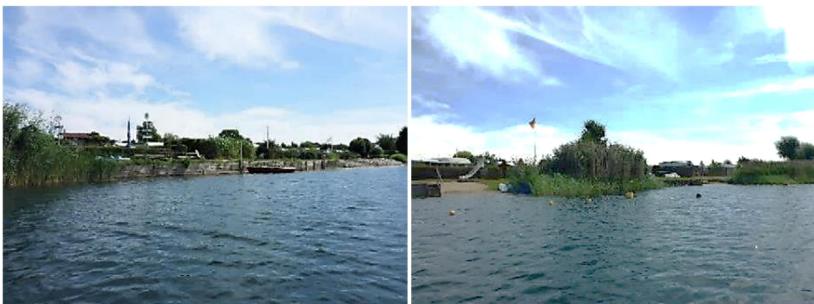
Abschnitt 8: Ufer im Bereich der Dauer-Campingplätze: Uferverbau mit Holz u. Steinen, Sandstrände
