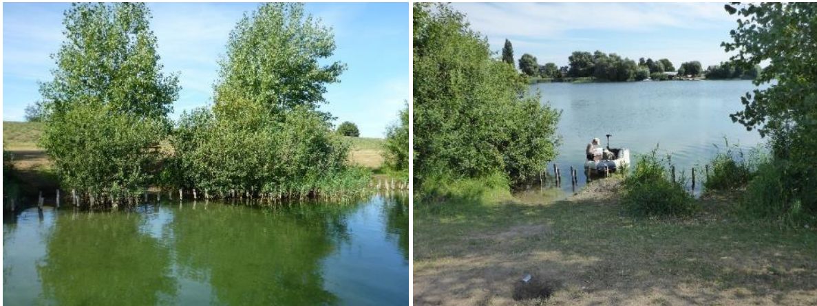
Drei dicht beieinander liegende Badezugänge und Reste der alten Uferbefestigung (Holzpfähle)
